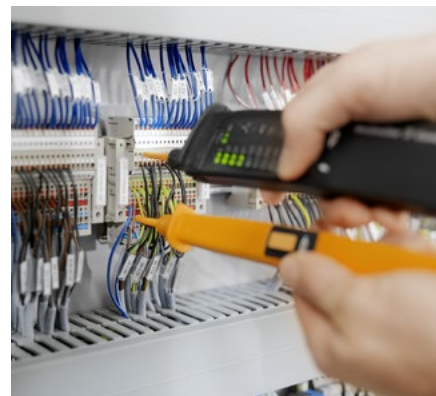
Fehlersuche mit zweipoligem Spannungsprüfer inkl. Prüfspitze nach IEC 61243-3
