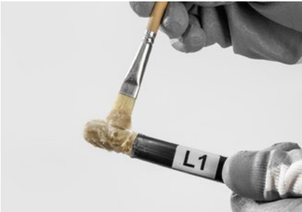
Bedecken Sie den Leiter rundum mit neutralem Fett.
