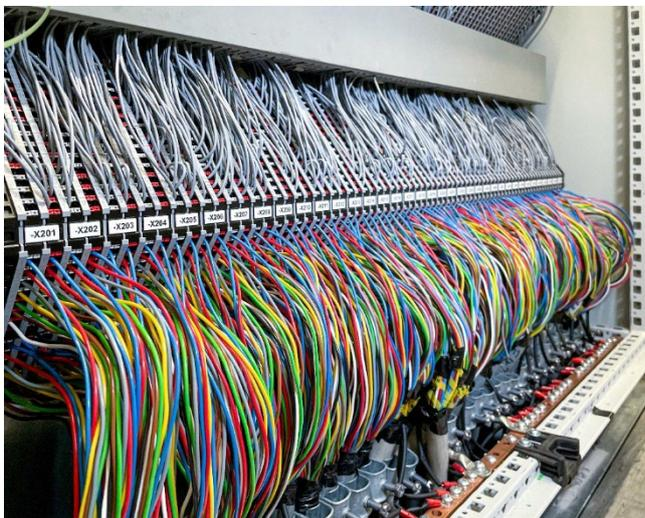
Bis zu 8.800 Anschlusspunkte auf nur zwei Meter Tragschiene
