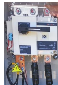
Abbildung 7: Beispiel für den Abstand zwischen den Eingangskabeln in einem Lasttrennschalter.
