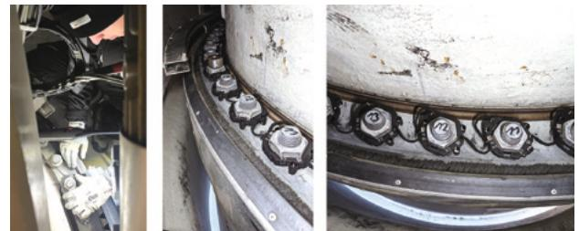
*Die TwinCap®-Sensoren werden um die Muttern platziert und durch starke Neodym Magnete in den Sensoren gesichert.*
